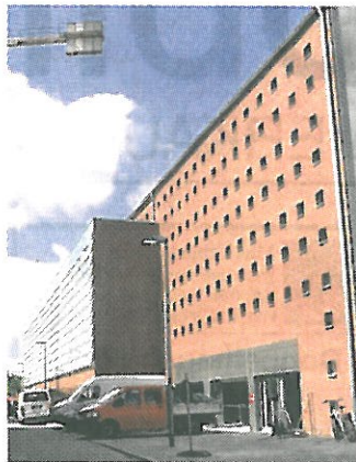
Das neue Parkhaus „Am Hafen“. Foto: M.H.
