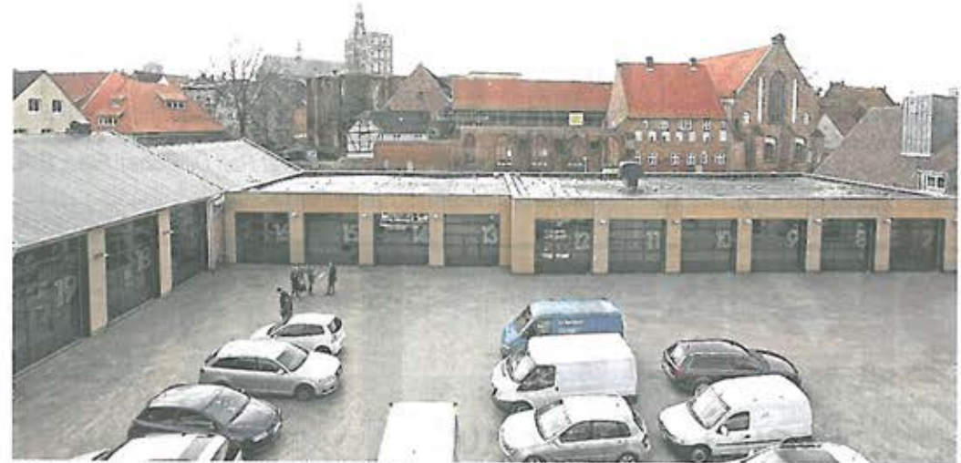
Blick auf die Fahrzeughallen. Etwa 16 Fahrzeuge des Sanitäts- und Betreuungszuges, der Hundestaffel, der DLRG, der Wassergefahrgruppe sowie der Feuerwehr finden hier Platz. Foto: C.R.
