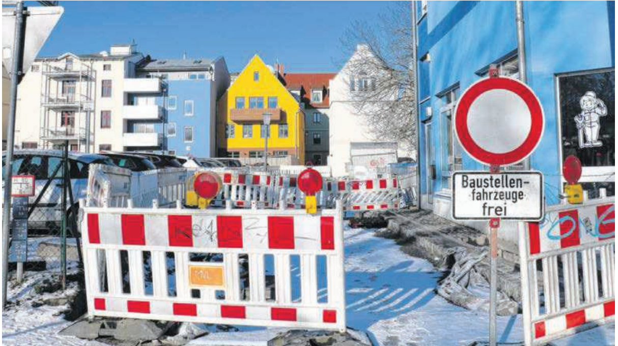
Die Sanierung der Blauturmstraße soll in diesem Jahr beendet werden.
