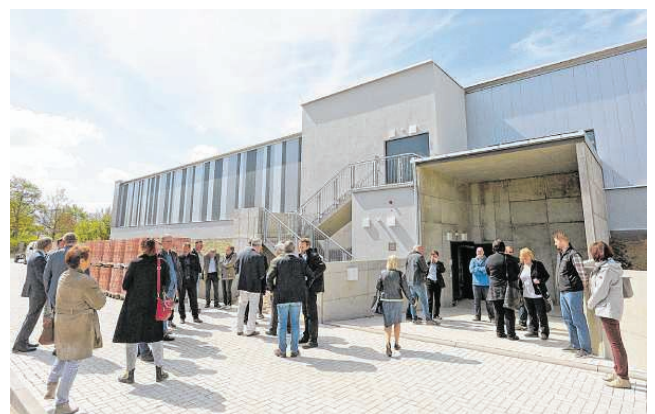
Zwei Jahre hat der Umbau der ehemaligen Nachrichtenzentrale an der Schwedenschanze 6 zum Zentraldepot für Kulturgüter gedauert.
