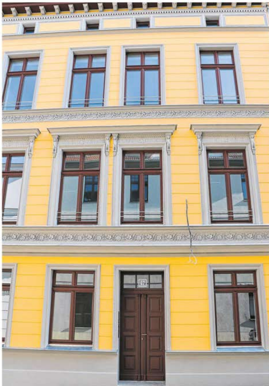
Nach anderthalbjähriger Bauzeit ist die Frankenstraße 47 wieder ein Schmuckstück.
