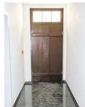
Ölplatten sind im neuen Flur verlegt worden.
